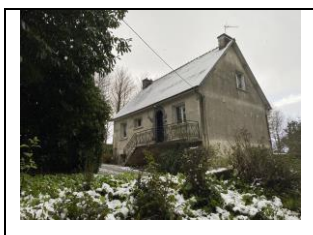
Photo générale de l'immeuble
